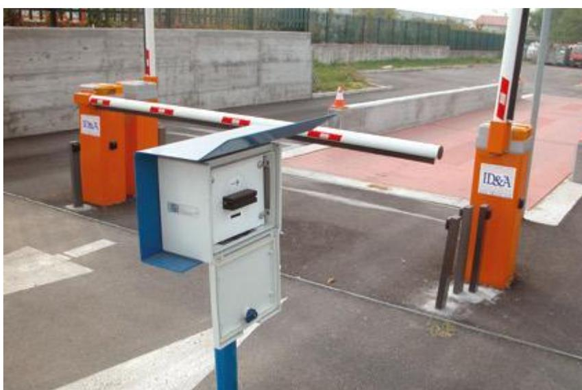
La soluzione prevede l'utilizzo della tessera (badge) data in dotazione agli utenti per conferire i rifiuti all'interno della isola ecologica. La tessera può essere dotata di banda magnetica, di chip elettronico oppure di transponder. All'esterno della/e sbarra/e sarà posizionato un/due lettore/i di badge con il rispettivo palo ancorato a terra.
